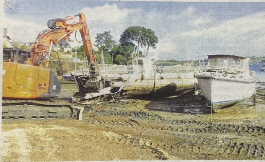
14 épaves ont été enlevées de la baie de La Landriais, la semaine dernière.
